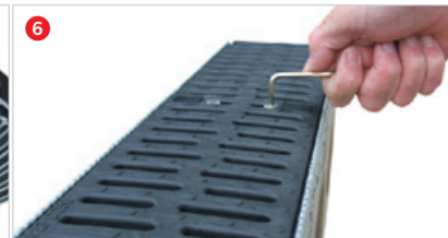
Placera galleret i rännan och dra skruvarna med nyckel.
